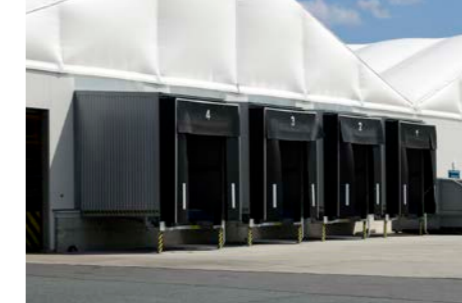
Yükleme Rampası / Loading Dock
